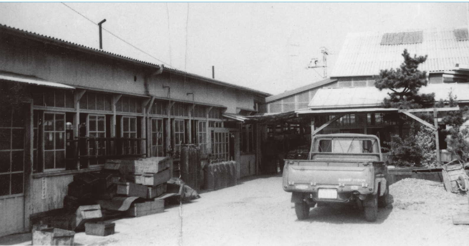
1961年(昭和36年)頃の南工場。左手が1号棟、正面が2号棟。1964年(昭和39年)にはトラックの位置に4号棟が完成。
